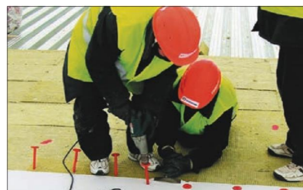
Рис. 5.4.5 Натяжение мембраны
