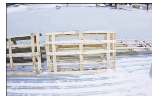
Рис. 3.1.3 Правильная склейка перехлестов пароизоляции в системе с основанием из профлиста
