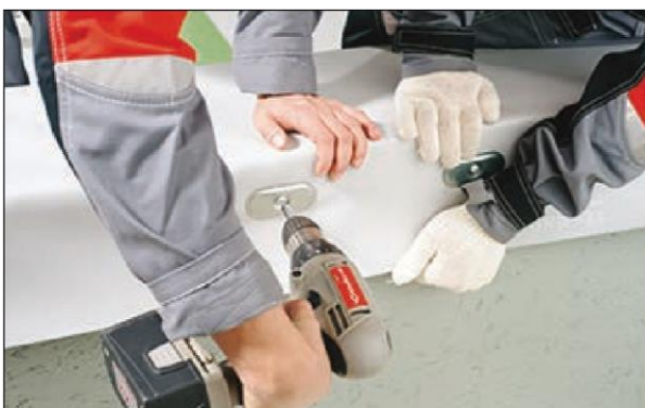
13. Прикрепите мембрану механически с наружной стороны парапета. Для предотвращения замачивания фасада уста-
