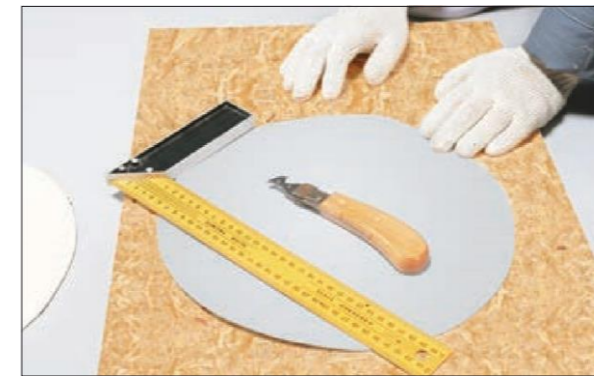
11. Вырежьте еще одну круглую заготовку из неармированной мембраны V-SR.
