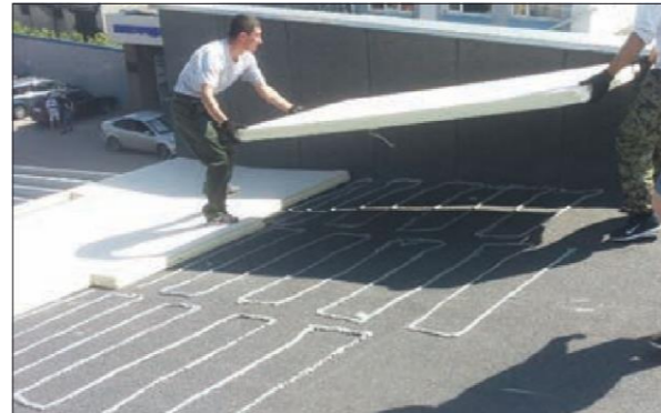
Рис. 2.9.4 Приклеивание плит PIR на Клей-пену
