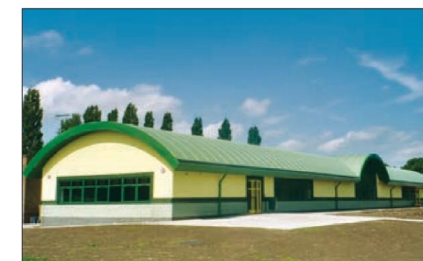
Рис. 4.8.2 Вид мембранной кровли с имитацией фальца
