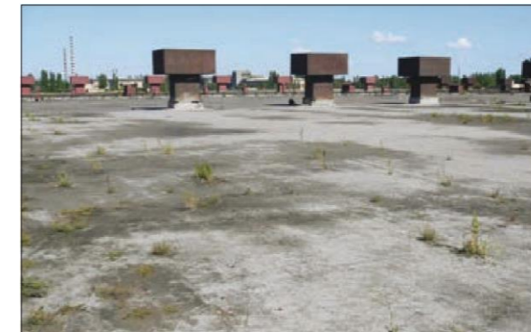
Рис. 2.9.1 Старая битумная кровля
