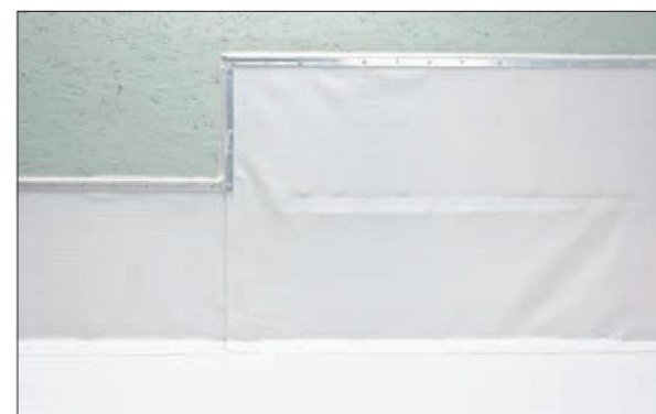
21. Возможный вариант перепада высот Швы, сделанные вручную, обработайте жидким
