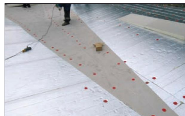
Рис. 3.3.16 Изображение разуклонки в ендове между воронками
