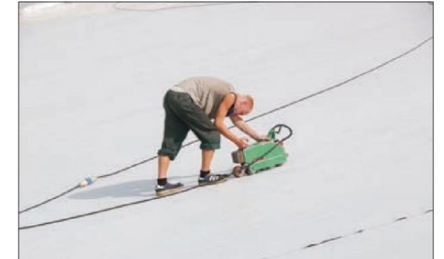
Рис. 2.9.8 После приклейки к основанию — мембрана на сваривается обычным образом
