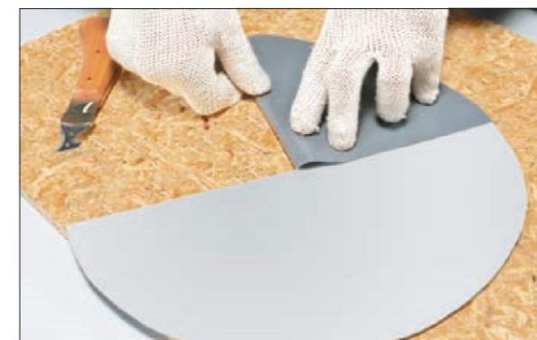
15. Загните получившийся сегмент и прикатайте его разваликом. рез кровельным ножом.
