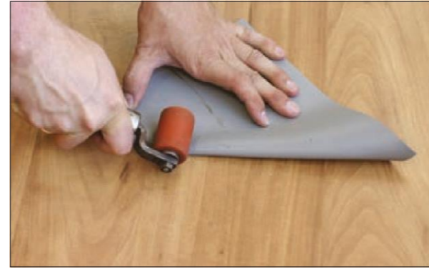
2. Прикатывая валиком складки по диагонали, находим середину квадрата и отмечаем угол. Для этого из неармированного материала маркером. вырезается квадрат 20×20 см.
