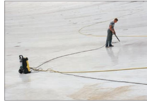
Рис. 2.9.5 – Рис. 2.9.6 Подготовьте старое основание: очистите, обеспыльте, просушите
