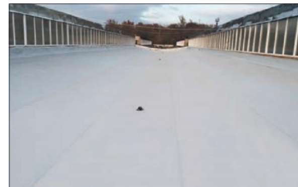
Рис. 2.10.3 а, б Вид кровли после реконструкции полимерными мембранами с доутеплением
