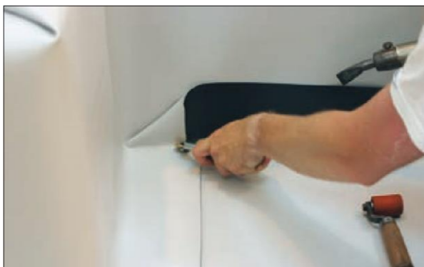
11. С помощью ручного фена заваривается конверт по периметру. Ширина шва не менее 20 мм.
