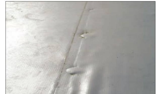
Рис. 3.5.7 Дефект сварного шва
