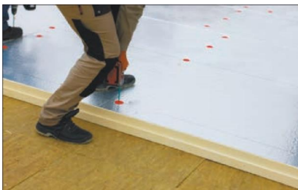
Рис. 2.4.1 Монтаж системы ТН-КРОВЛЯ Смарт PIR
