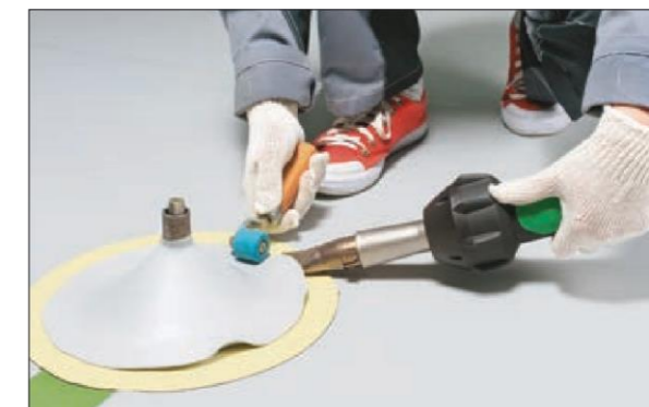
28. Сделайте воздушный карман с помощью латунного ролика. При этом давите латунным роликом «наружу», чтобы обеспечить необходимое натяжение мембраны.
