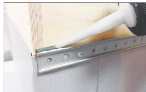
23. В качестве замены краевой рейки можно использовать прижимную стальную рейку
