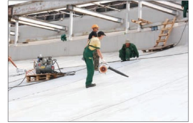
Рис. 2.9.5 – Рис. 2.9.6 Подготовьте старое основание: очистите, обеспыльте, просушите
