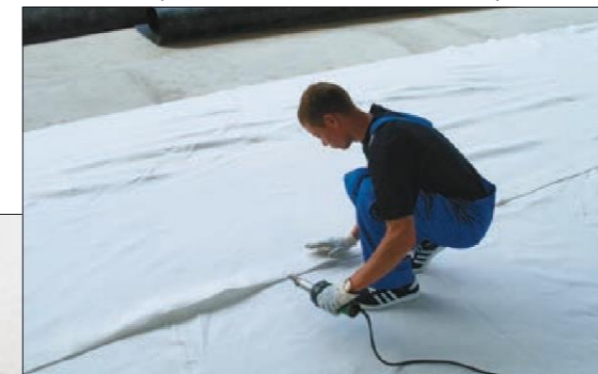
Рис. 3.3.1 Сварка полотнищ геотекстиля между собой
