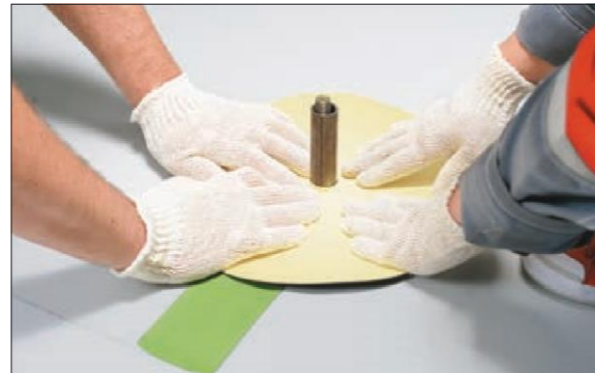
8. Затем быстро, пока мембрана не остыла, наденьте заготовку на проходку малого пока мембрана в диаметра. пластичной.
