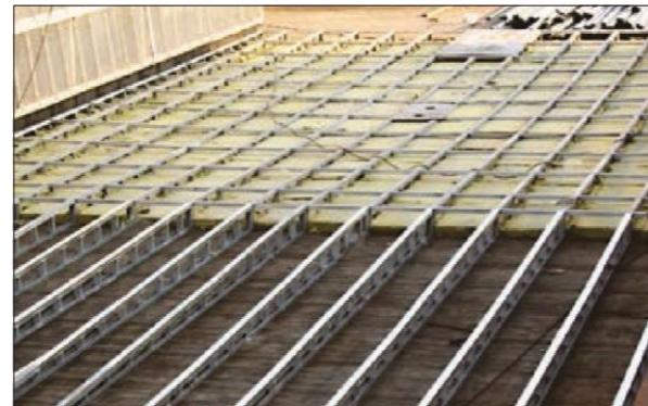
Рис. 3.3.3 Вариант устройства разуклонки
