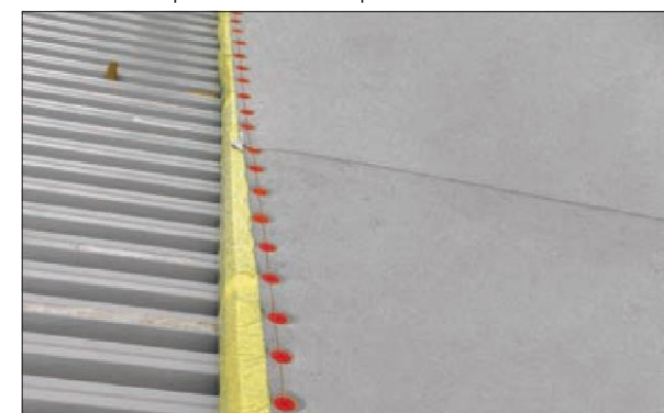
Рис. 3.1.7 Защита теплоизоляции от намокания
