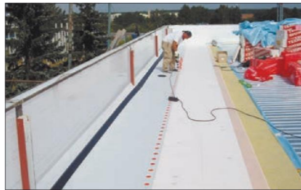
Рис.3.5.17 Монтаж метровых рулонов ТЕХНОНИКОЛЬ
