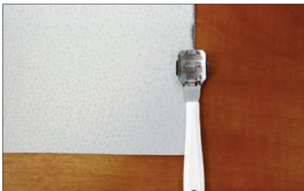
Рис. 5.2.15 Фиксация Т-образного шва металлической пластинкой
