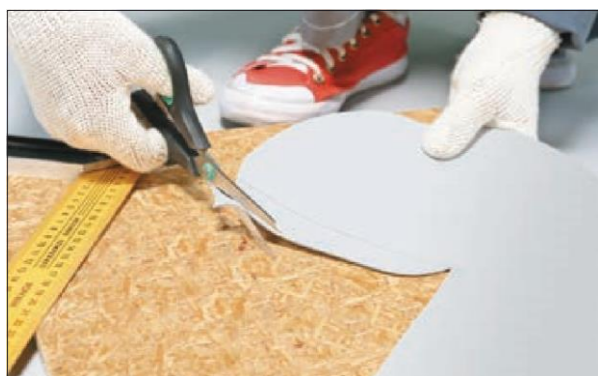
17. Закруглите углы с помощью ножниц.
