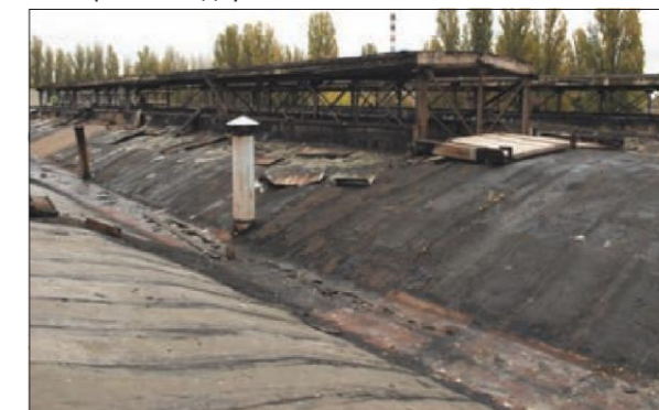
Рис. 2.10.3 а, б Вид кровли после реконструкции полимерными мембранами с доутеплением
