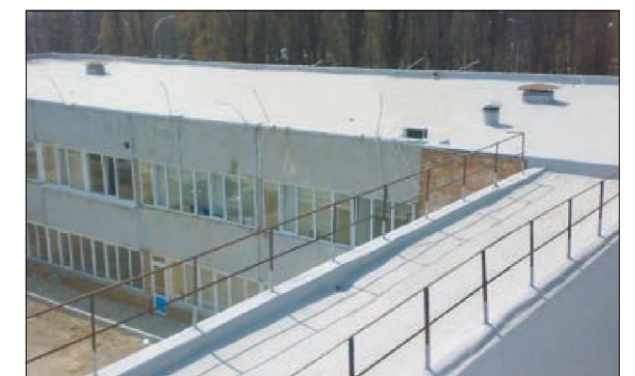
Рис. 2.9.2 Вид кровли после ремонта полимерными мембранами с доутеплением
