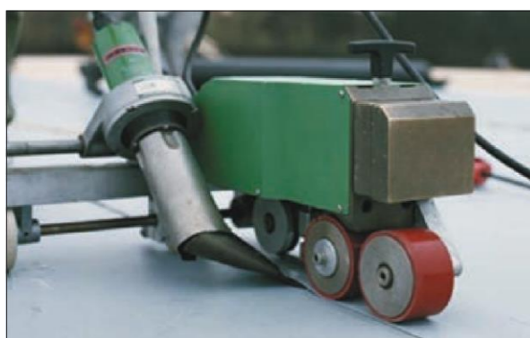
Рис. 5.2.1 Процесс автоматической сварки
