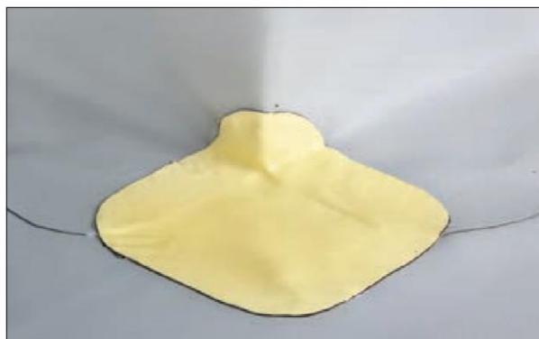
11. Вид готового примыкания
