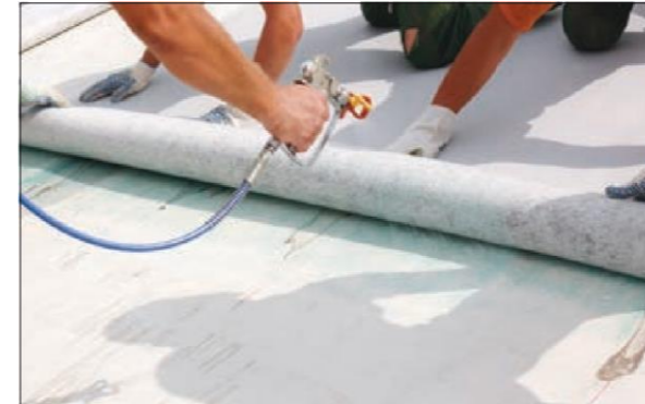
Рис. 2.9.7 Процесс нанесения клея на основание мембрану
