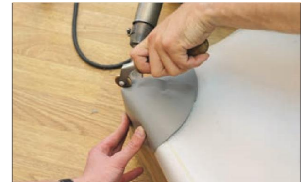
8. Заготовку укладываем на подходящий угол, например, стола и привариваем последовательно все стыки, начиная от отрезанной полосы.
