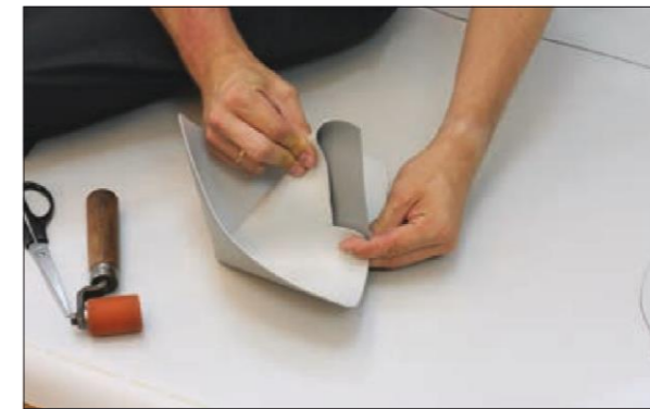
7. Снова складываем угол так, чтобы вырезанная полоса оказалась внутри кармана.
