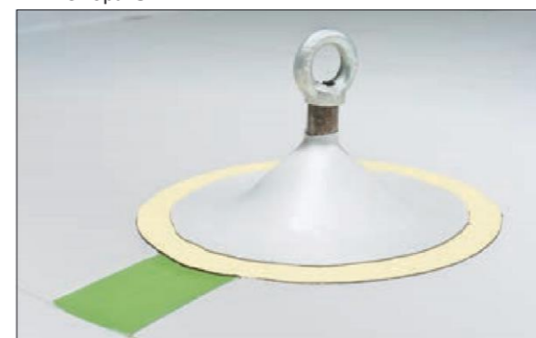
29. Проверьте качество сварных швов пробником. Сверху конус стяните хомутом и заполните ПУ герметиком.
