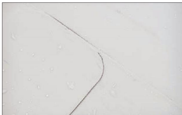
Рис. 5.4.1 Скругление углов мембраны
