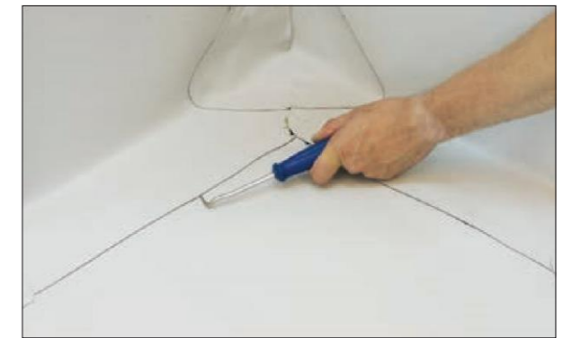
10. Проверяем качество швов при помощи по месту, чертилки. участке угла.
