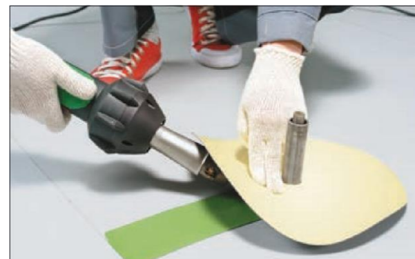
9. Прихватите заготовку точечно в нескольких местах. Снимите фаску с краев заплатки на величину сварного шва (не менее 30 мм).
