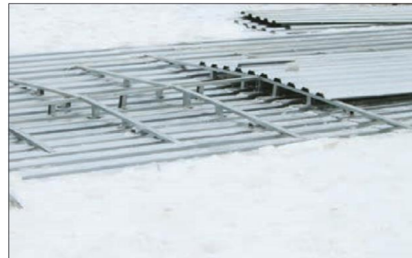
Рис. 3.3.4 Вариант устройства разуклонок
