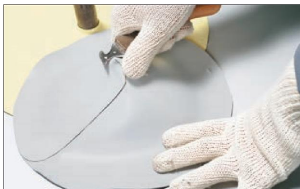
23. Сделайте надрез кровельным ножом на вершине конуса.
