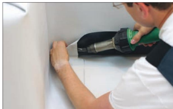
12. Особенно тщательно следует выполнять сварку внутренней части уголка. При работе использо-
