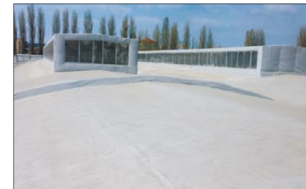
Рис. 2.10.3 а, б Вид кровли после реконструкции полимерными мембранами с доутеплением
