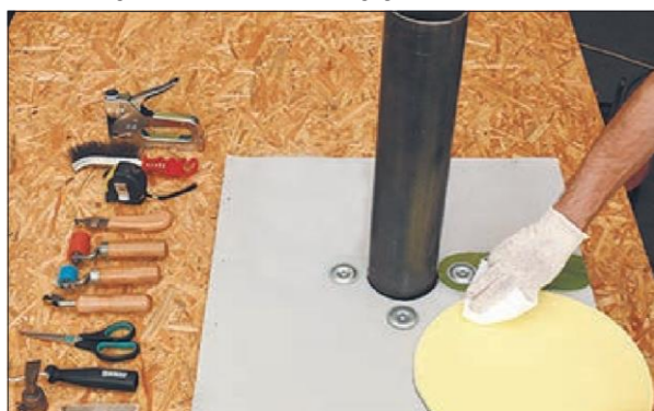
11. Вид готового примыкания
