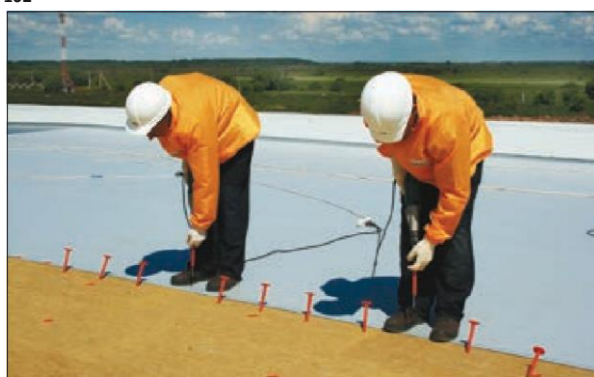
Рис. 5.4.5 Натяжение мембраны
