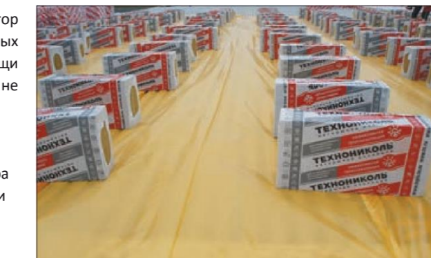
Рис. 3.1.4 Укладка пароизоляционной пленки ТЕХНИКОЛЬ
