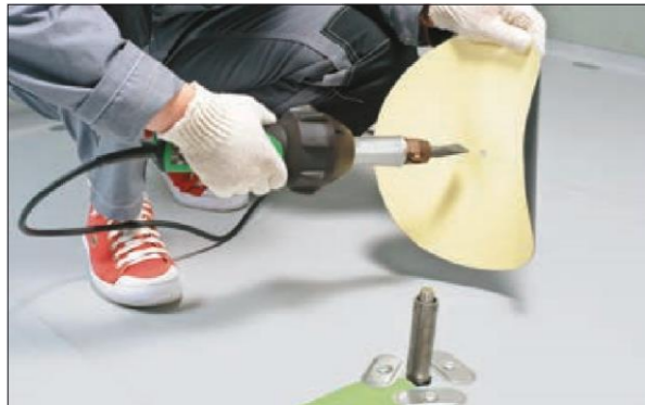
7. Прогревайте заготовку горячим воздухом, равномерно водят фенем вокруг отверстия, в месте прогрева не станет диаметра. пластичной.
