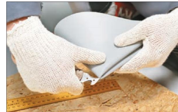
11. Вырежьте еще одну круглую заготовку из неармированной мембраны V-SR.
