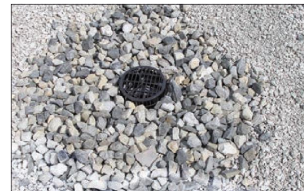
Рис. 2.7.5 Увеличение фракции балласта вокруг воронки
