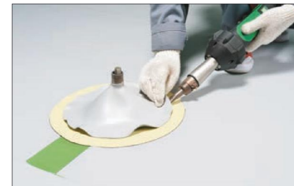
26. Точно прихватите конус за «юбку» к основному кровельному ковро.
