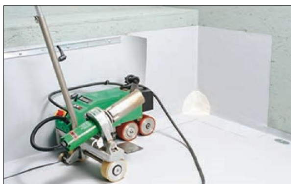
17. Закруглите все углы. Приварите полосу к основному кровельному коврику при помощи автомата-предварительно снимите фаску с края нижней части мембраны.
